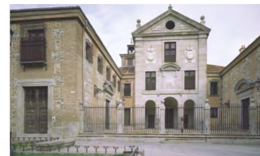
Facade of the Convent of La Encarnación
